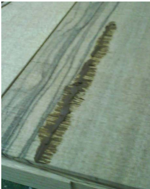
תיקון נקע, סדק, על ידי פתיחתו עם מכשיר עם ראש חד ומילוי מחדש עם חומר עיסת עץ.
