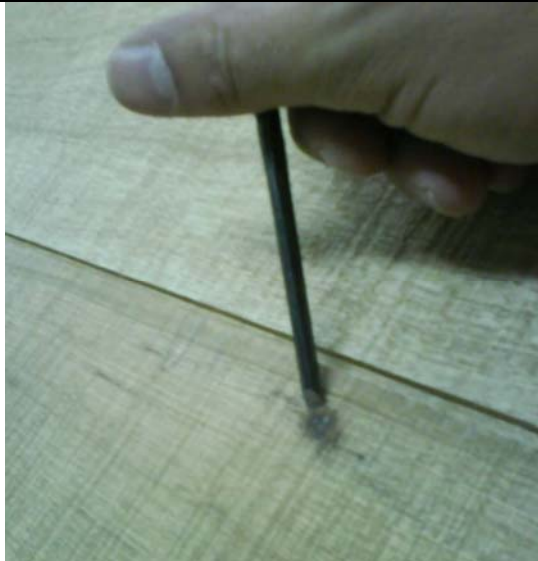
דבק שפרץ החוצה מחור בעץ בהדבקה, יש לנקות אותו אחרת זו תהייה נקודה לבנה בצבע (הדבק לא מקבל צבע על עצמו)
